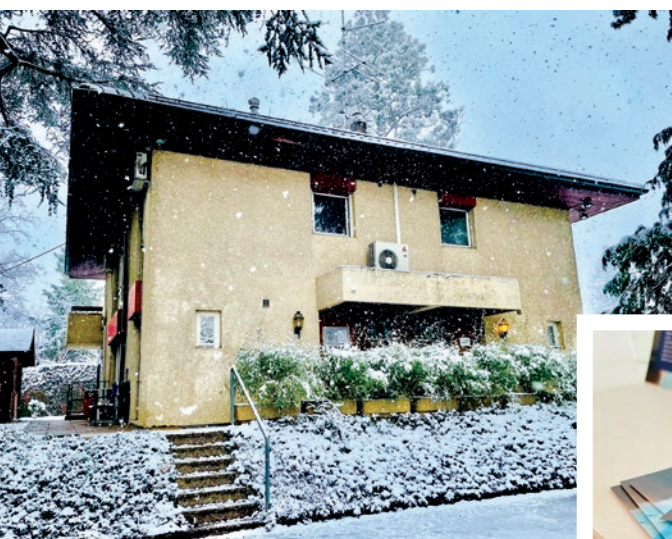
▲ Fondation Phénix Centre Chêne, site historique inauguré en 1986.
